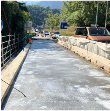
Abb. Nr. 29: Verdunstungsschutz sprühen
