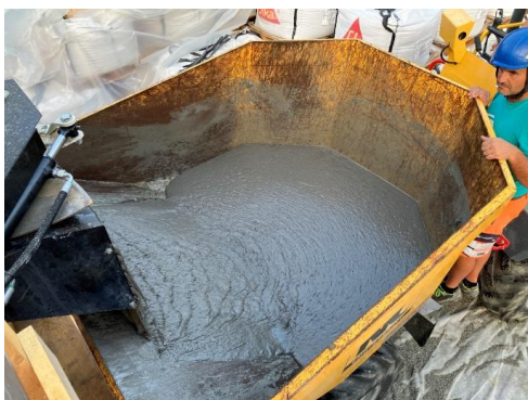
Abb. Nr. 15: Enladen der Mischung in ein Dumper
