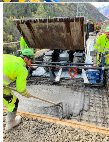
Abb. Nr. 19-22: UHFB-Einbau und Verteilung mittels Schaufeln und Betonrädchen
