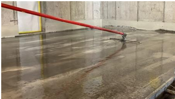
Abb. Nr. 27: Glätten der UHFB-Oberfläche (II)
