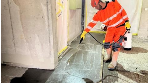
Abb. Nr. 25: Sprühen des Zwischennachbehandlungsmittels
