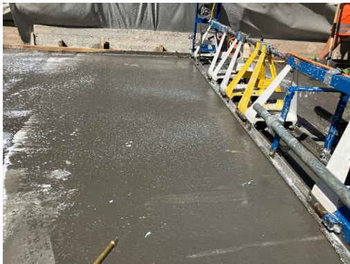
Abb. Nr. 23, 24: Belagsfertigung mittel Rüttelbohlen
