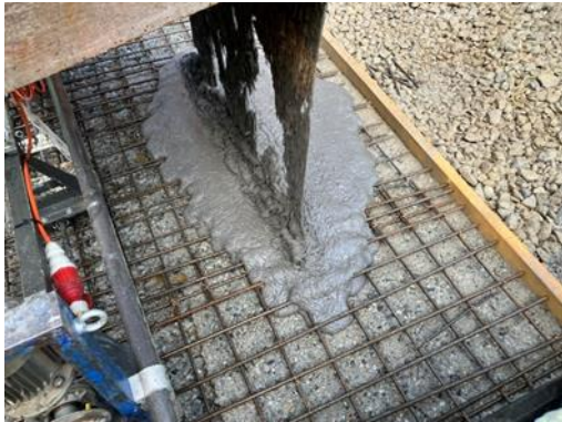
Abb. Nr. 17: Giessen auf die Einbaustelle
