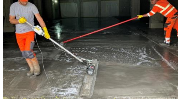
Abb. Nr. 26: Glätten der UHFB-Oberfläche (I)
