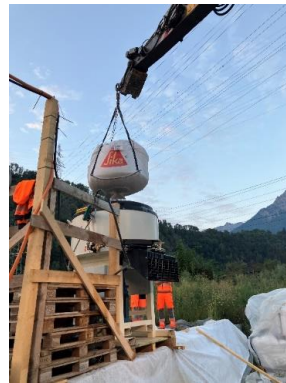
Abb. Nr. 12: Bigbag handling mittels Krahn/Schaufelbagger
