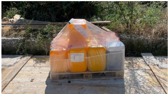
Abb. Nr. 5: Lagerung der nötigen Materialien neben Mischplatz
