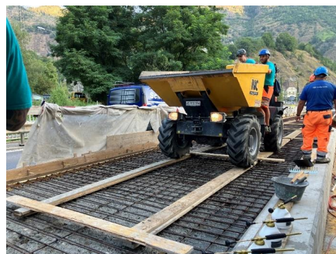
Abb. Nr. 16: Transport zur Einbaustelle mittels Dumper
