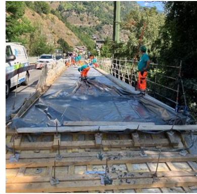
Abb. Nr. 31: Schutz mit Plastikfolie
