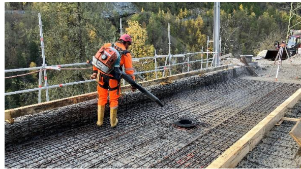
Abb. Nr. 7: Entfernung von stehendem Wasser
