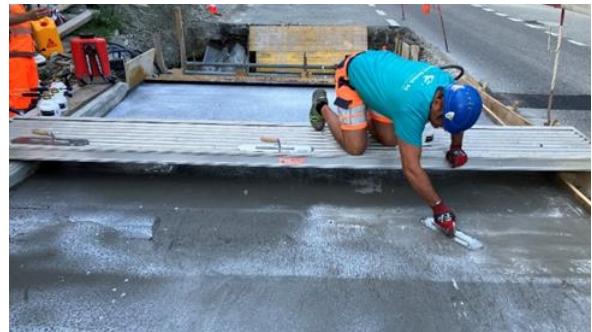
Abb. Nr. 28: Glätten der UHFB-Oberfläche (III)
