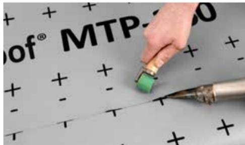
Alle Handschweißungen werden mit der 20 mm Düse ausgeführt.
