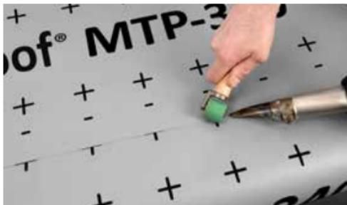
Bei optimaler Verschweissung entsteht keine Verfärbung am Nahtrand. Das Vlies sollte im Zuge der Verschweissung eingebettet sein.
