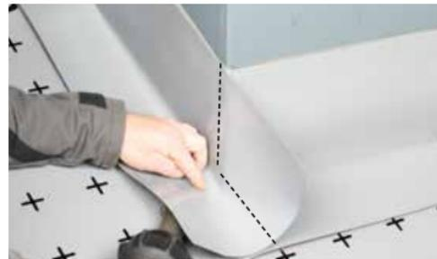
Alle Seiten mit SikaRoof® MTP Detailband ausführen und diese auf die Unterdachbahn heften.
