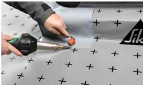
Das SikaRoof® MTP LUX Formteil mit der Unterdachbahn verschweißen.
