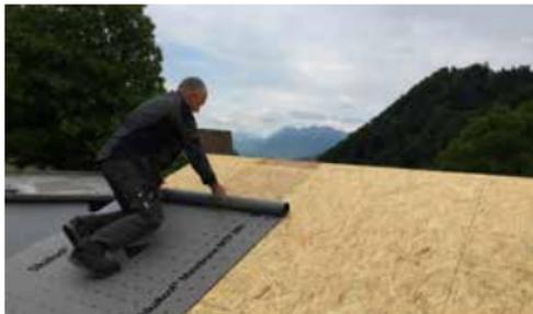
SikaRoof® MTP wird mit Vorteil direkt über den First verlegt.
