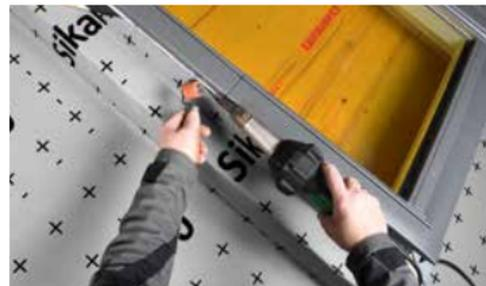
Die überstehende Unterdachbahn abschneiden und bis zum oberen Rand aufkleben.
