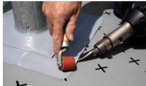
Den SikaRoof® MTP Rohranschluss richtig positionieren und mit der Unterdachbahn verschweißen. Um den Schutzgrad zu erhöhen, kann die Aufbordnung zusätzlich mit einem Sarnatape® abgeklebt werden.
