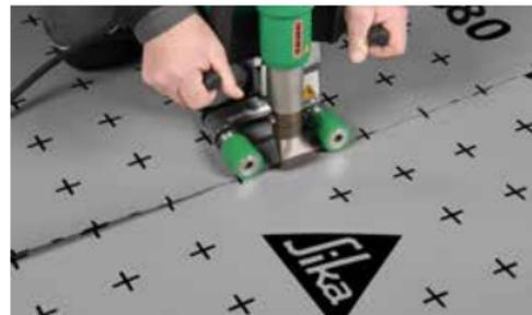
Die Verwendung eines Halbautomaten, wie z.B. der Leister Uni Drive 500, erhöht die Verlegeleistung.
