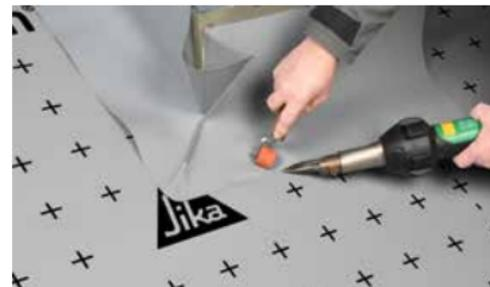
SikaRoof® MTP Eckanschluss universal mit der Unterdachbahn verschweißen.
