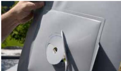
Den Rohrdurchmesser sowie die Dachneigung bestimmen und die entsprechende Ellipse anzeichnen. Ausschneiden (~ 15 - 20 mm kleiner als der Durchmesser), erwärmen und über das Rohrstülpen.
