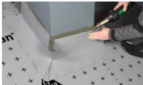
SikaRoof® MTP Eckanschluss universal positionieren und aufkleben.
