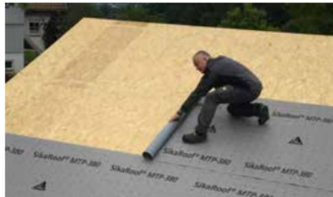
Erfolgt die Verlegung quer zur Dachneigung sind die Schweissnähte grundsätzlich ohne Konternnähte zu überlappen.
