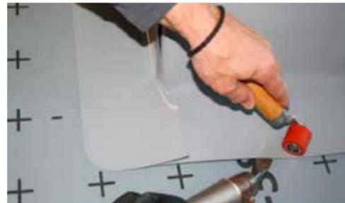
das Band auf die Unterdachbahn verschweißen.
