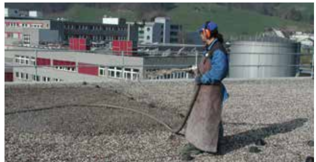
Anspritzbegrünung | Semis hydraulique
